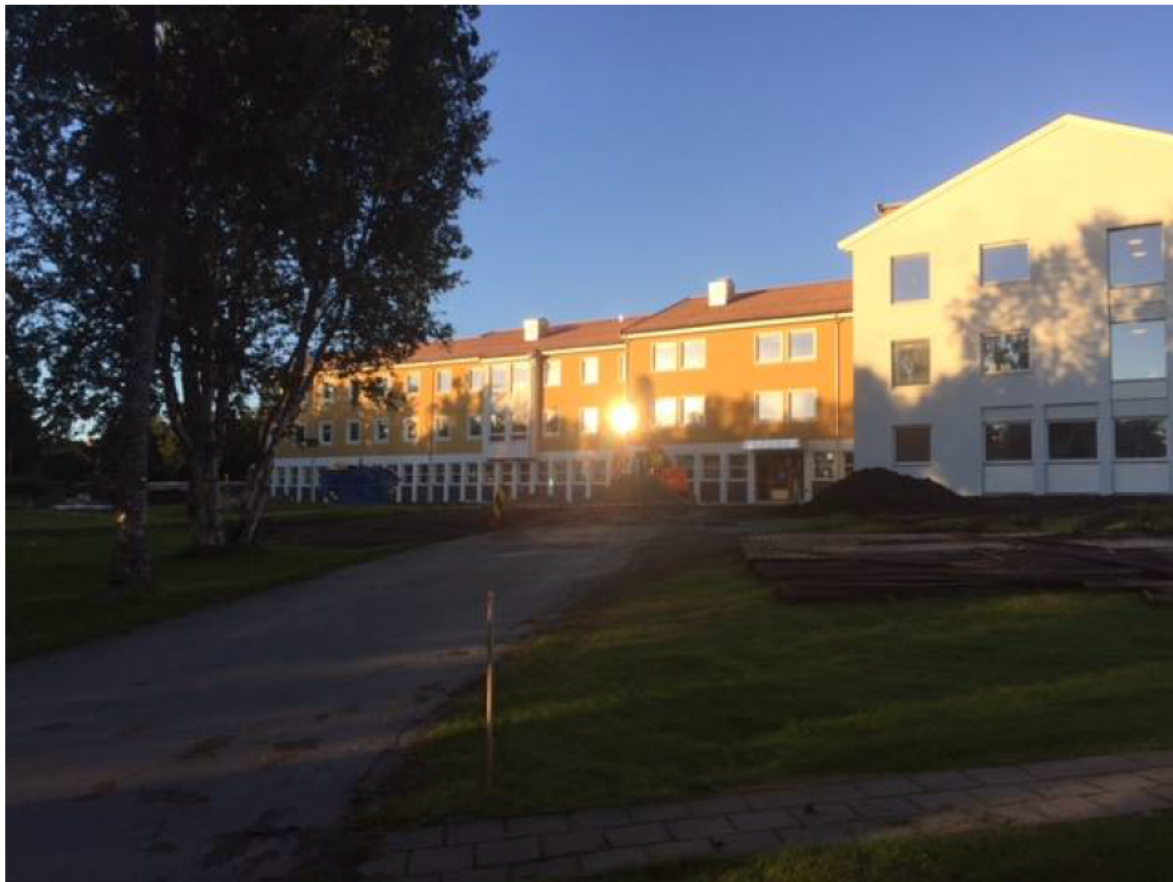
Nyrenovert fasade på Bygg 7 - i høstsol
