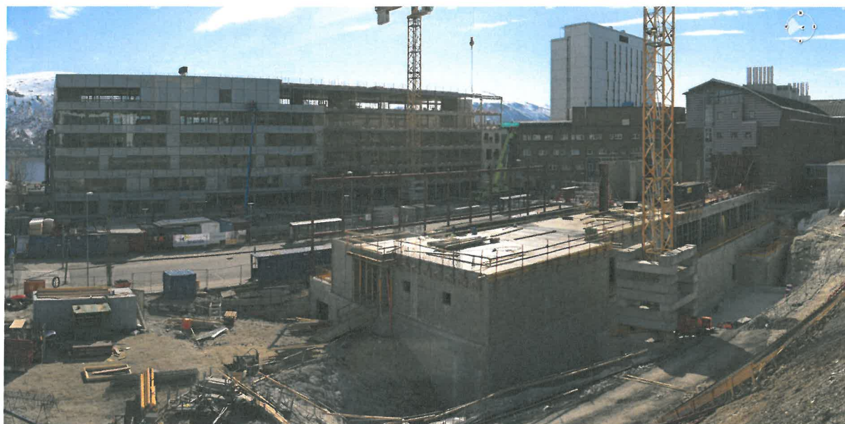
Byggeområdet ved UNN Breivika 30. april 2016
