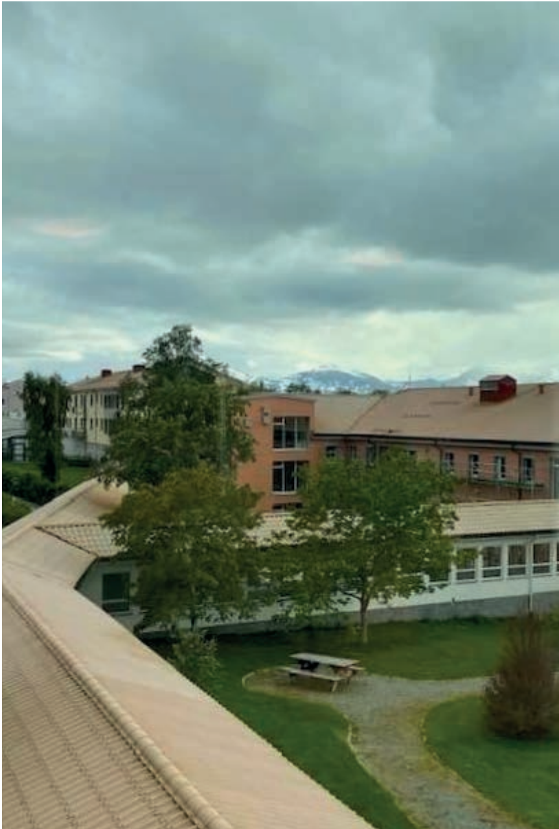
Hage ved bygg 6
