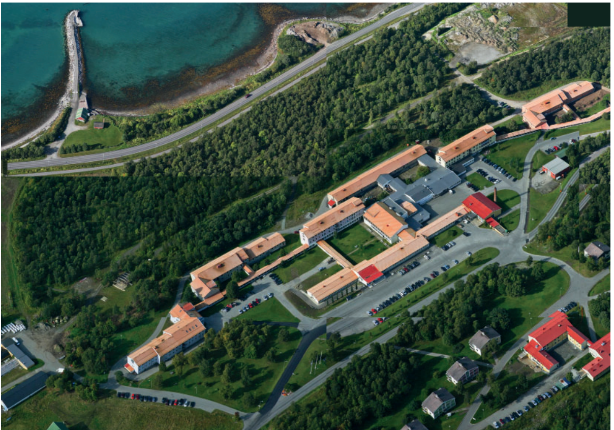
Luftfoto Åsgård - tomt Å1 innenfor eksisterende bygg - tomt Å2 vest
